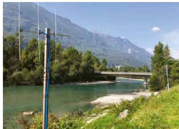
Antenne per telemetria radio sul fiume Ticino.
