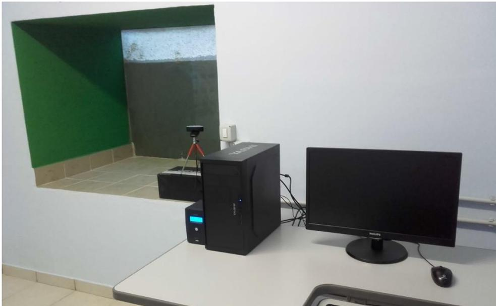
Foto 6: esempio di una cabina di videocontrollo posizionata in un passaggio per pesci.
