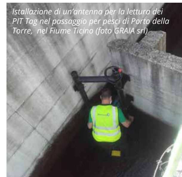
Installazione di un'antenna nel passaggio per pesci di Creva, nel Fiume Tresa (foto GRAIA srl)
